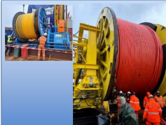
Spooling winch per sbobinare cavo FO Reel Hub drive per supportare e svolgere la bobina MT (Ø8,2m, 250t)
