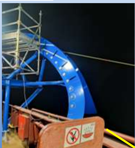
Scivolo di varo con rulli e marche per riscontro visivo della tensione di catenaria
