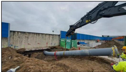
Figura 5.10 - Varo dei nuovi spool di raccordo a cavallo del muro perimetrale del cantiere Ex Sarom
