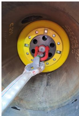
Figure 4.15a / b – Funne messaggera connessa al pig di lancio (sinistra) e alla testa di tiro del Cavo TLC (destra). Si nota la terminazione con redancia metallica connessa ad un golfare “wide body”
