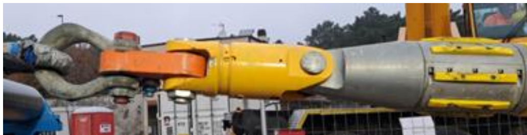
Figura 5.1 - Rigging di tiro del cavo MT
