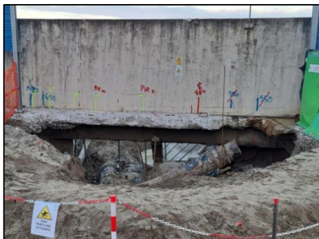
Figura 5.11 - Ingresso delle condotte PIR all'interno del Cantiere Ex-Sarom prima e dopo l'installazione dei nuovi spool di risalita
