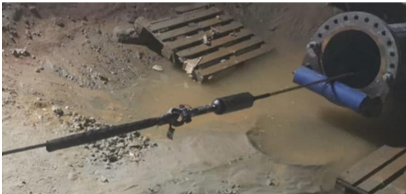
Figure 4.15a / b – Funne messaggera connessa al pig di lancio (sinistra) e alla testa di tiro del Cavo TLC (destra). Si nota la terminazione con redancia metallica connessa ad un golfare “wide body”
