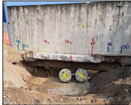
Figura 5.11 - Ingresso delle condotte PIR all'interno del Cantiere Ex-Sarom prima e dopo l'installazione dei nuovi spool di risalita
