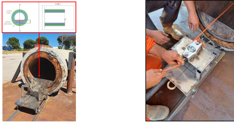
Figure 5.5a / b - Dettaglio piastre saldate agli imbocchi / Dinamometro carrello in asse con la condotta PIR
