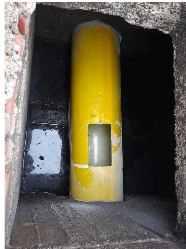
Il liner arriva già impregnato in cantiere, il posizionamento avviene per inversione all'interno del tubo ospite. Successivamente le estremità vengono sigillate e si procede al gonfiaggio del liner e al passaggio di lampade a LED.
