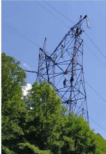
**Figura 1. Intervento su guasto della linea elettrica AT dovuta a eventi meteorologici**
