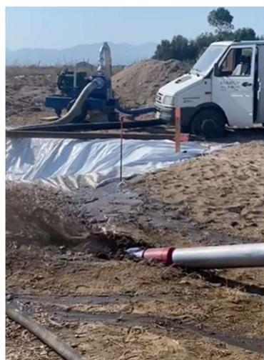
Figura 5 – Realizzazione del foro pilota
